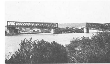
Pierre Lambert La plupart des convois de déportés passèrent sur ce pont de la ligne de Soissons
