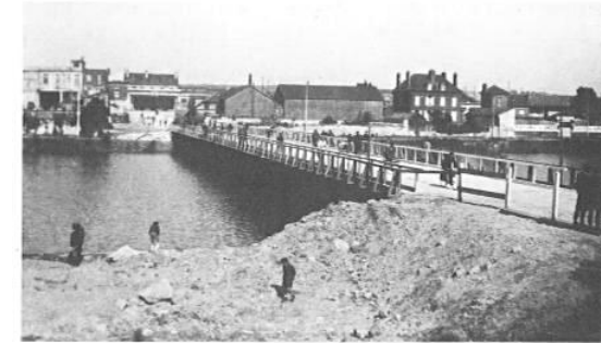
P. Lambert Le quatrième pont provisoire construit avec passe navigable face à la gare remplace un pont de bateaux
